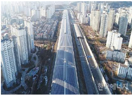
<그림 4> 영동선 방음터널 태양광 설치 출처: 한국에너지신문 (2018.01.02.)
