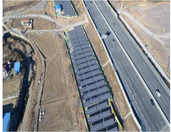
<그림 1> 남해고속도로 진주-마산구간 유희부지 태양광발전 출처: 한국도로공사
